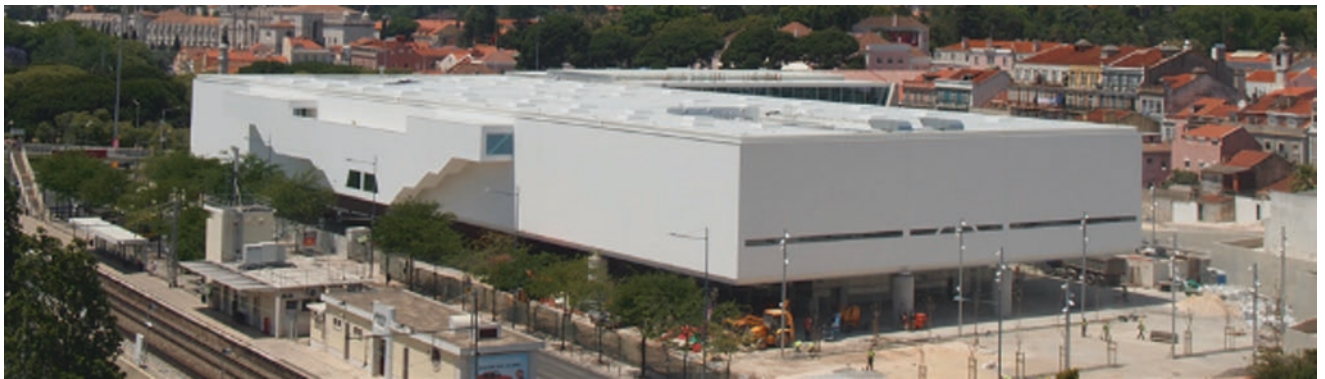
Fig. 16 External view from the east side of Av. da Índia
